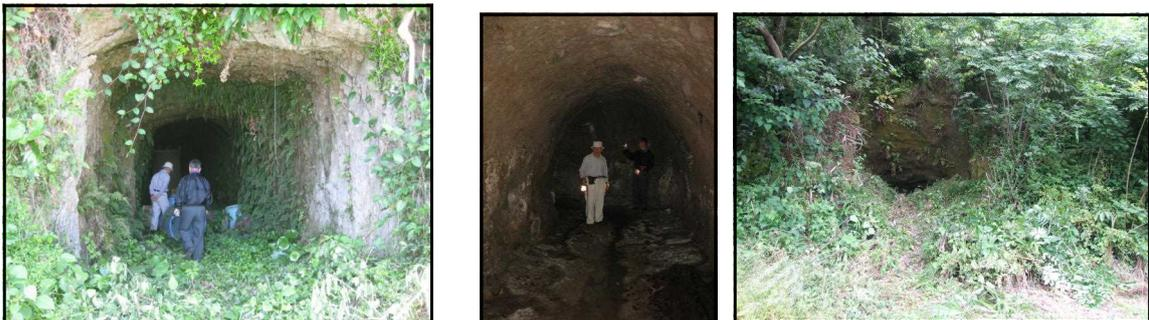
□左：黒崎の補給品格納壕の入口。方形扉部の構造 □中：壕内部の様子 □右：崩落した対面側の崩落入口
