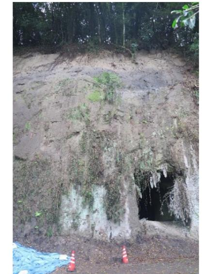
人吉海軍飛行場地下魚雷調整壕と周辺崖面の崩落状況
