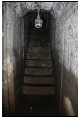
上左写真：防空壕A側入口の外観 上右写真：内部状況と機械設置台座 下左写真：排水溝と溜升 下右写真：B側入口に向けての直行する内部階段
