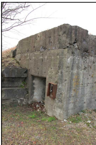
第二十一海軍航空廠本部防空壕 長崎県大村市森園町 上左：A側入口とRC建屋 上右：上部の換気筒 中左：大村市指定の標柱 中右：B側入口と配電盤 下：防空壕全景
