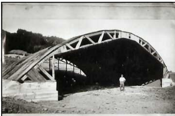
写真－３：左 木製掩体壕事例（20m×20m規格） 立川航空機製造所疎開工場での施工例 写真－４：右 膠着梁大張間工場（20m×30m規格） 山梨県飯野町龍王現場での施工例
