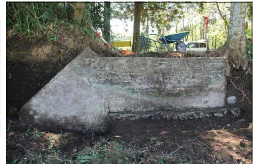
写真－２ ２号掩体壕第１トレンチ左側手前袖部のコンクリート基礎部の敷設状況と堀方ライン
