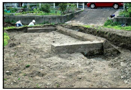
写真-8 ロタコ3号掩体壕コンクリート基礎部全体図
