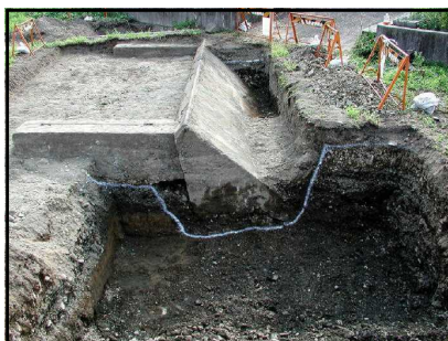
写真-8 ロタコ3号掩体壕コンクリート基礎部全体図
