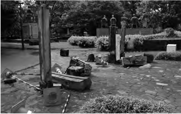
写真1 第六師団長官舎門の倒壊・破損 門柱部の倒壊。熊本市中央区高橋公園。
