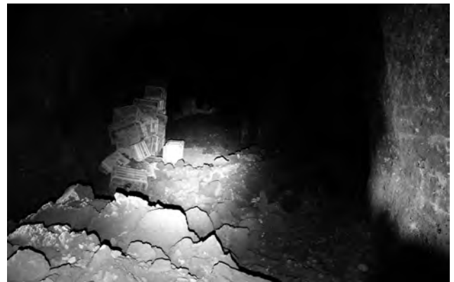
写真7 陸軍大刀洗航空廠菊池分廠飛熊地下壕第2号壕の崩落 壕入口部の天井落下・崩落。菊池市泗水町飛熊。
