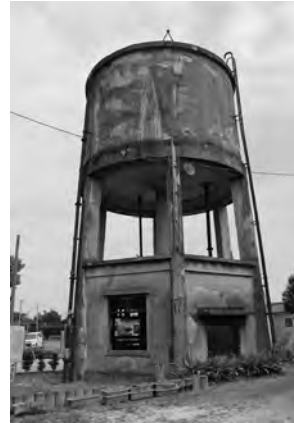
写真5・6 菊池飛行場花房給水塔のモルタル剥離 6本ある柱の西側柱及び受水部モルタル剥離。菊池市泗水町。
