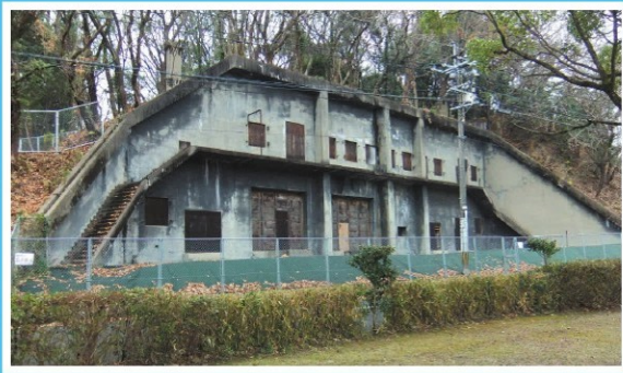
荒尾二造変電所
