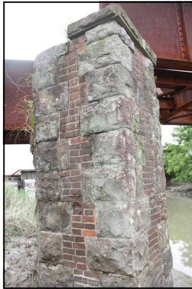
写真 8 第 1 橋脚南面の弾痕状況 写真 9 同橋脚先端部の角石状況 写真 10 同橋脚機銃弾痕跡
