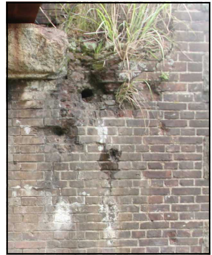
写真 8 第 1 橋脚南面の弾痕状況 写真 9 同橋脚先端部の角石状況 写真 10 同橋脚機銃弾痕跡
