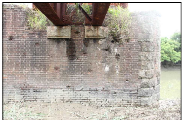
写真7 第1番橋脚西面の機銃弾・弾痕状況
