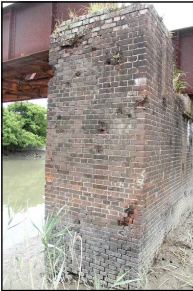
写真 8 第 1 橋脚南面の弾痕状況 写真 9 同橋脚先端部の角石状況 写真 10 同橋脚機銃弾痕跡
