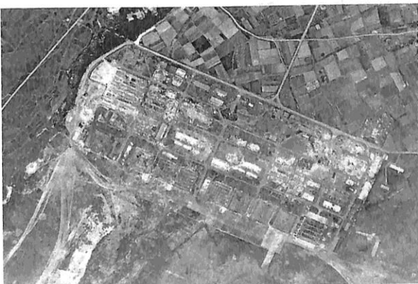
菊池飛行場の空撮写真。破損したままの格納庫や兵舎などが確認できた
