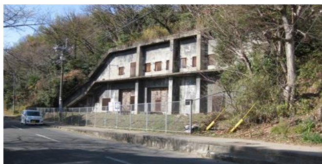
図5 東京第二陸軍造兵廠荒尾製造所変電所跡
