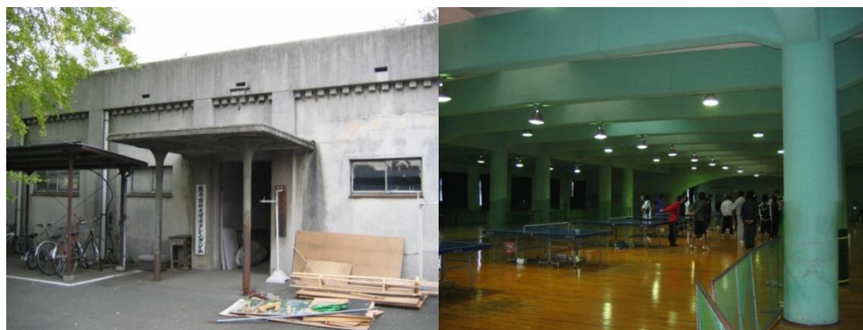
図2 歩兵第十三聯隊食堂（左は外観、右は内観）現熊本学園大学第2体育館
