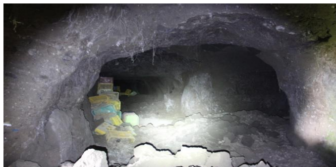
図3 陸軍大刀洗航空廠菊池分廠飛熊地下工場第2格納壕の崩落様子
